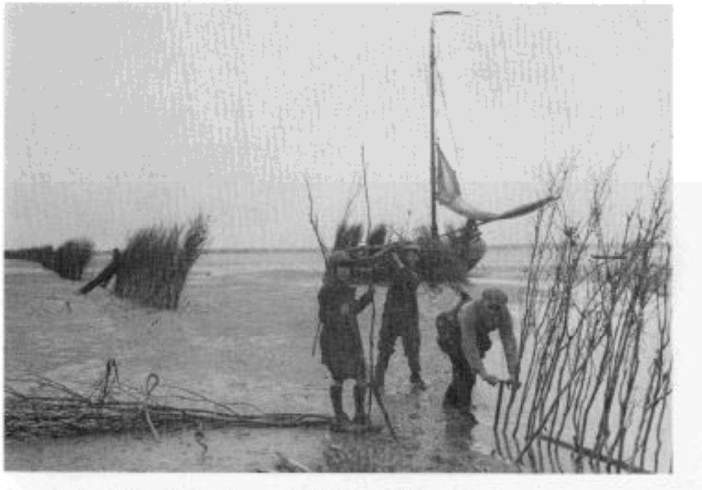
De weervisserij in de Oosterschelde. Het stekken van de weer in het vroege voorjaar is een zware arbeid, dikwijls te verrichten bij guur weer en lage watertemperaturen. In de bodem worden gaten geboord, waarin het hout wordt geplaatst. De vleuken van een weer kunnen wel 1 km lang zijn. Nabij het fuikgat wordt het hout zeer dicht opeen gezet en vaak nog extra versterkt met metaalgas (foto van der Aa).
